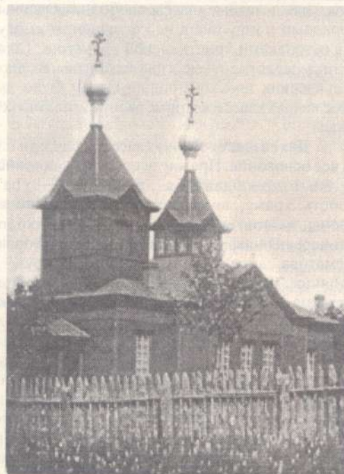
Храм Казанской иконы Божией Матери в Швянченеляй до разрушения
